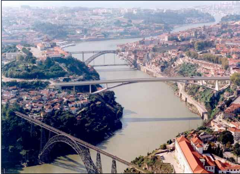
1877. Viaduc Maria Pia. Porto. Portugal
