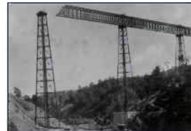
L'ouvrage encours de construction Image de l'Académie François Bourdon
