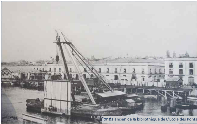
Mise en place de palplanches en béton armé
