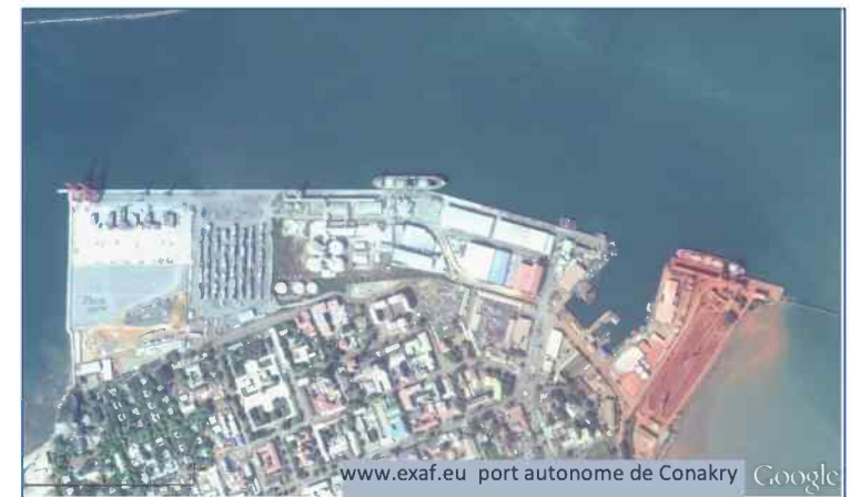
Vue aérienne du port de Conakry. 2016 (A droite stockage de minerai)
