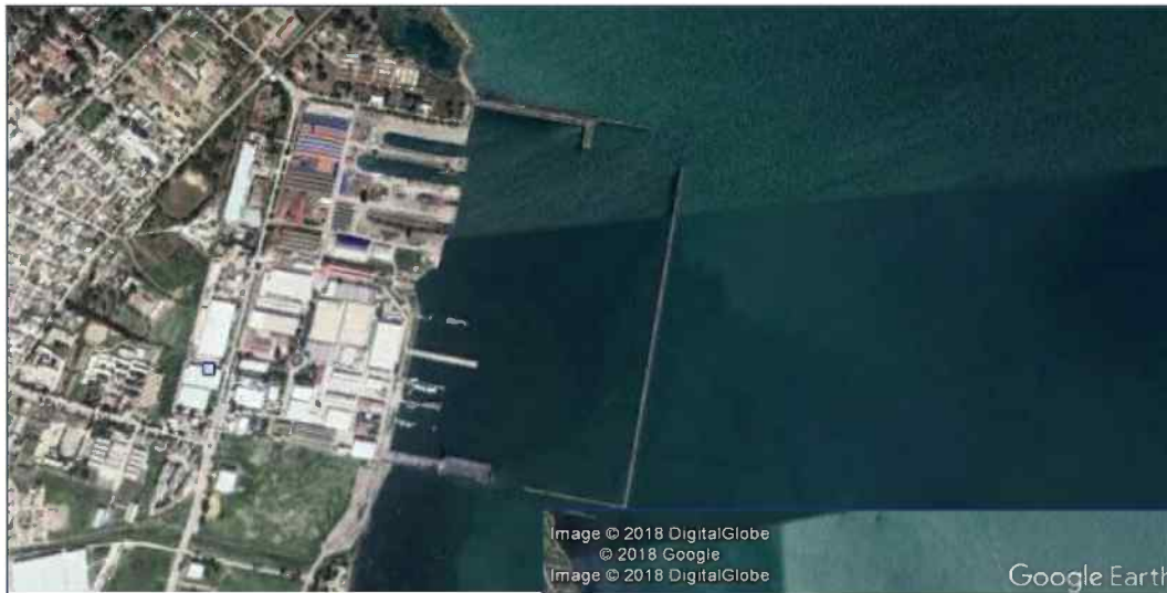
La base de Sidi Abdallah Vue aérienne. 2018
