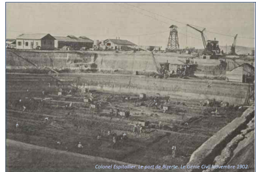
Le terrassement des formes de radoub.
