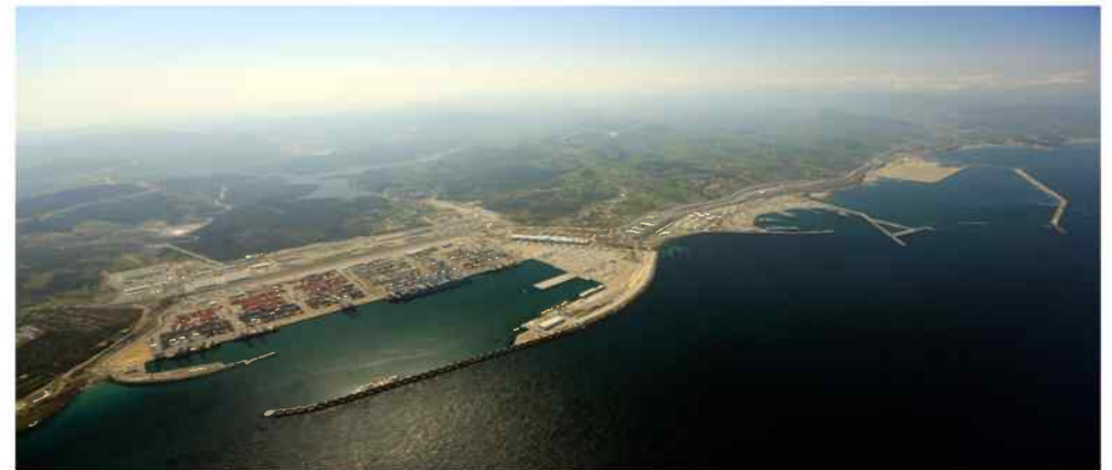
L'ensemble du projet – Photothèque Bouygues
