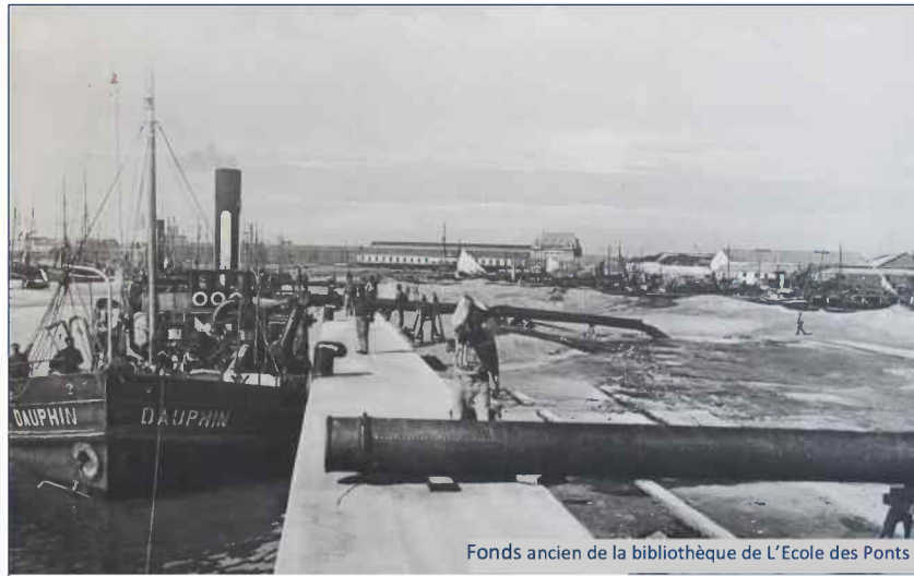
Remblayage hydraulique derrière les murs de quai
