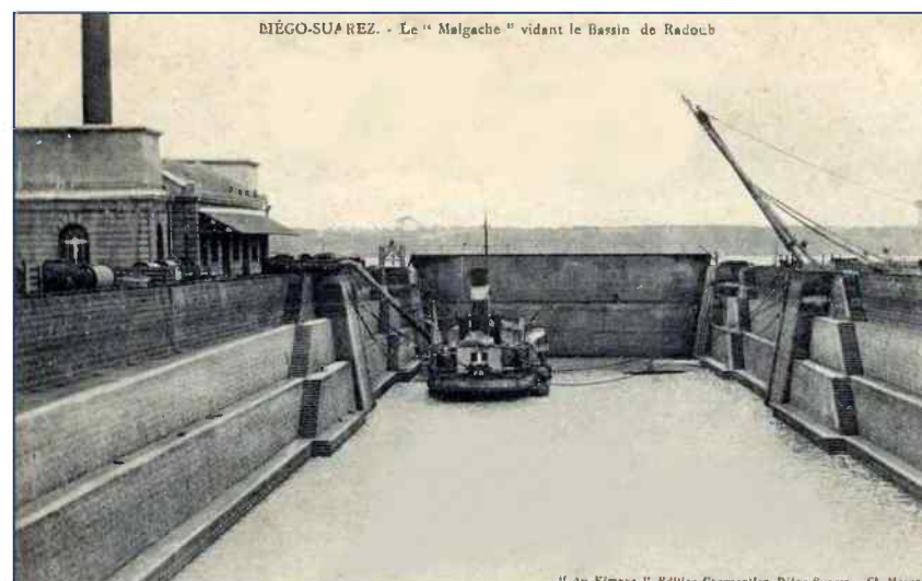
Le bassin de radoub en service
