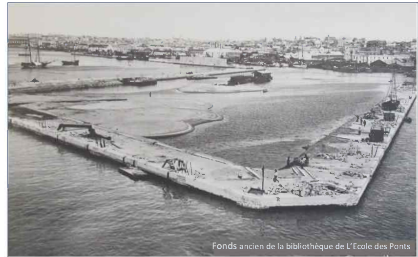
Exécution des remblais au môle B
