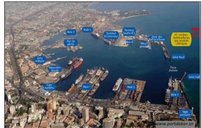
Le port de Dakar moderne. Vue générale
