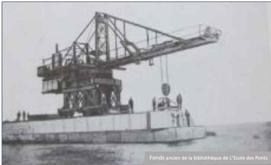
La grue Titan à vapeur de 150 tonnes
