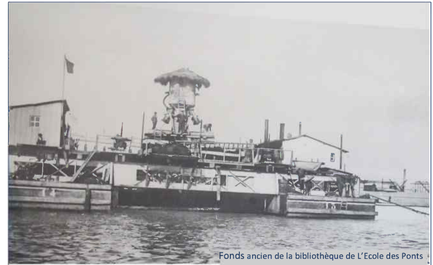
Atelier de travaux sous-marins réalisés à l'air comprimé.
