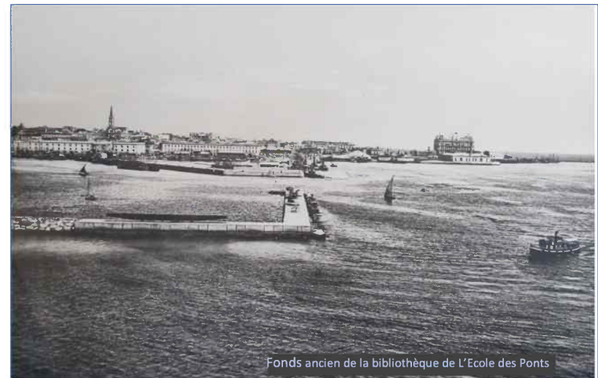
Entrée du port, vue du nord. Au premier plan, la digue de ceinture
