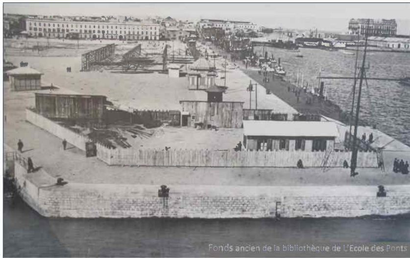
Môle remblayé, terminé, équipé
