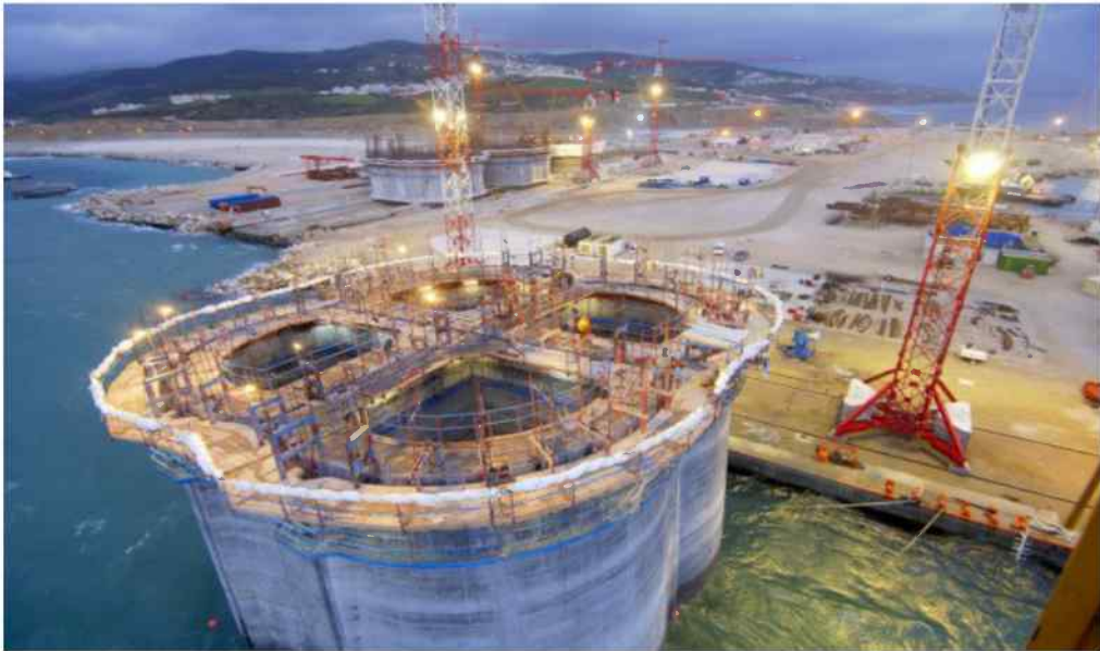
Caisson quadrilobé – Photothèque Bouygues
