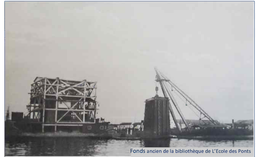
L'atelier mobile et le batardeau de construction des piles
