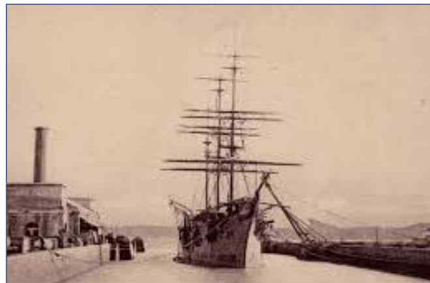
Entrée du premier navire, Le Vaucluse, dans le bassin de radoub (15 mars 1916)°
