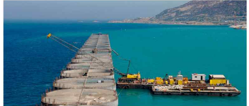
Digue en construction – Photothèque Bouygues
