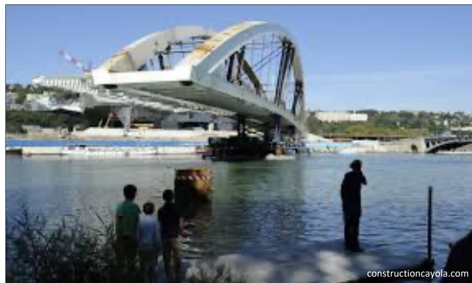
Transfert par barge de la structure du pont
