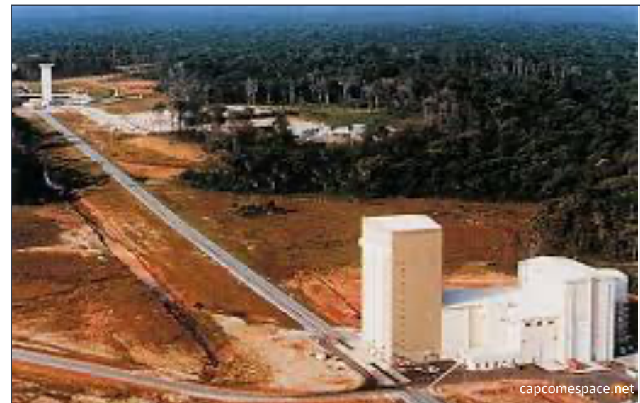
Bâtiment d'Intégration des Propulseurs, Ariane 5, (BIP)
