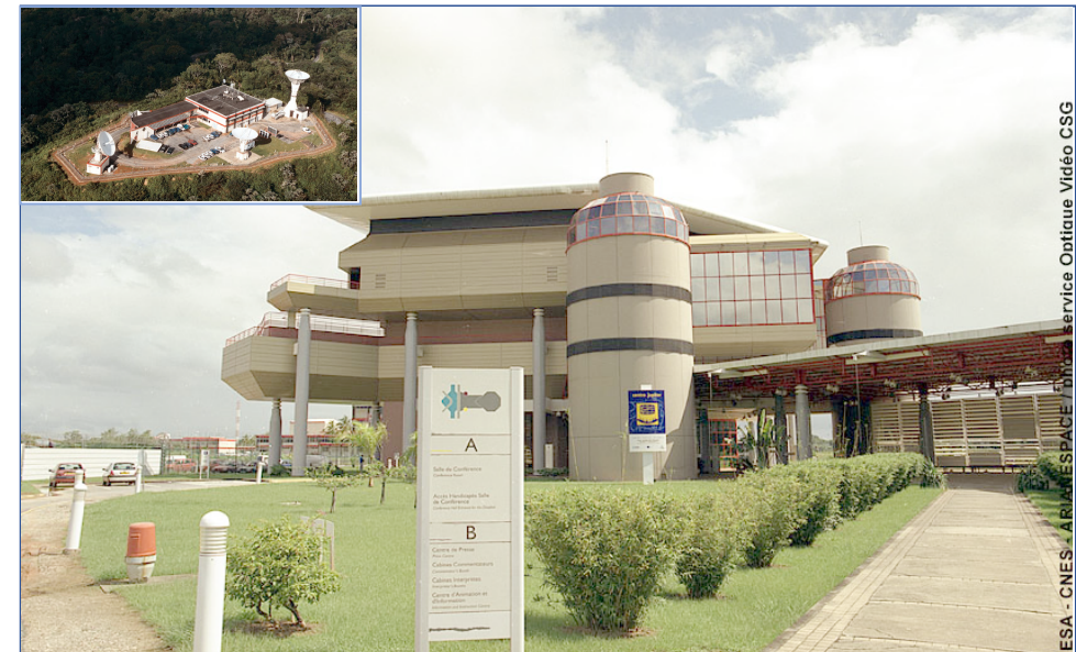
Le Centre de Contrôle des Lancements
