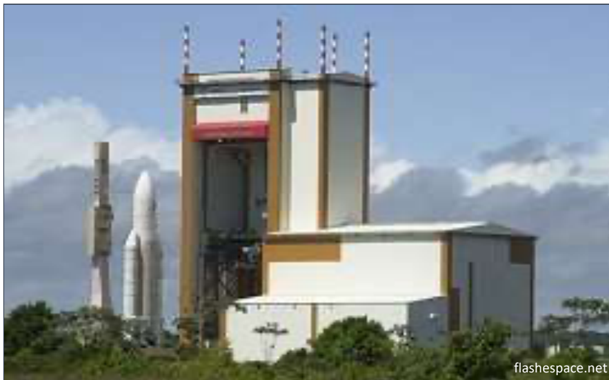
Bâtiment d'Intégration des Lanceurs, Ariane 5 (BIL)
