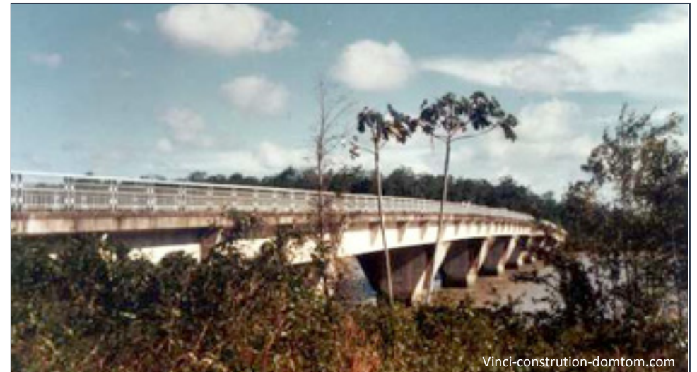
Pont de la RN 1 à Kourou
