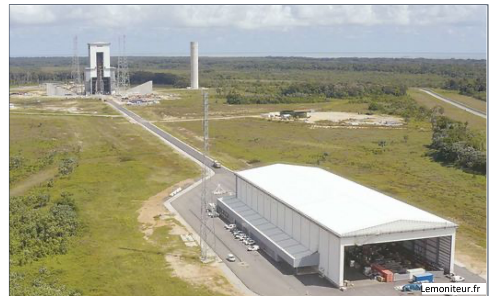
Le Bâtiment d'Assemblage Lanceur (BAL)
