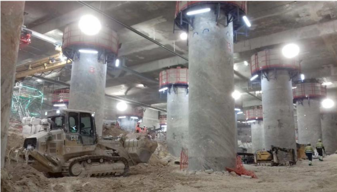
Vue récente du chantier (septembre 2020)
