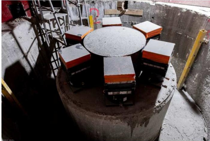
Vérins et camarteaux en tête de pilier
