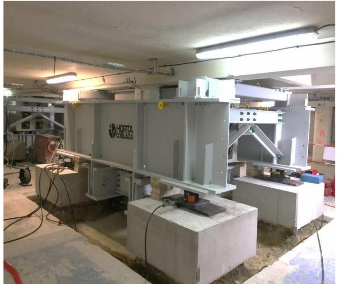
Charpente sur vérins
