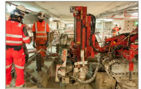
Phase 1: Micropieux sous faible gabarit (15 km ; 1600 u)
