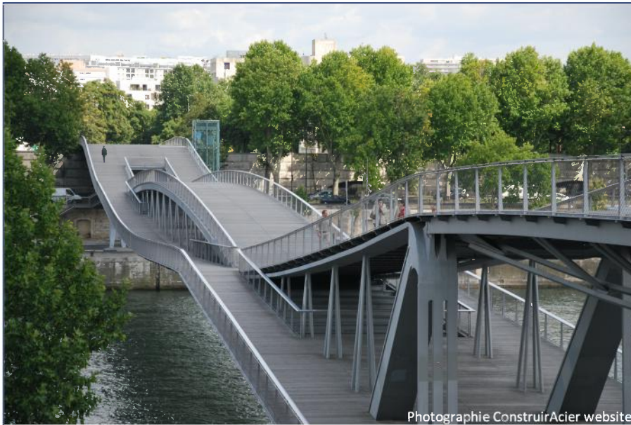
Passerelle Simone de Beauvoir. Paris (2006)
