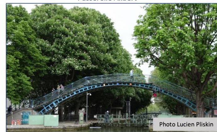
Passerelle de la Grange aux Belles
