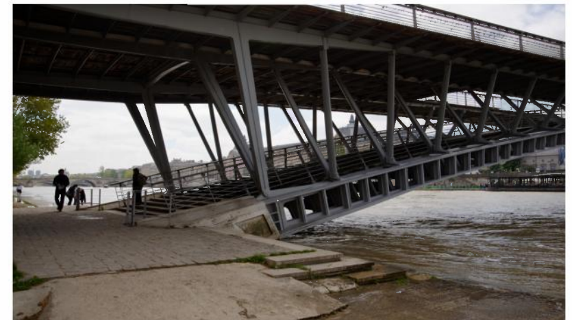
Accès depuis la rive droite de la Seine
