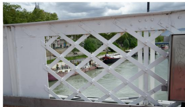
Garde-corps à claire-voie
