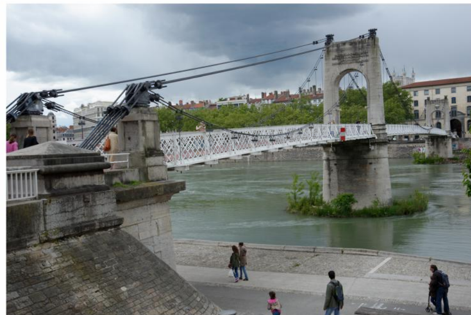
Câbles de suspension de la passerelle et d'ancrage des pylônes
