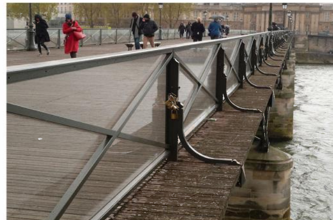
Fixation du nouveau garde-corps (photo Thomas Bresson - CC BY 4.0, Wikimedia)
