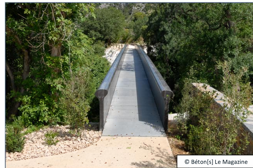
Vue des 2 poutres en T
