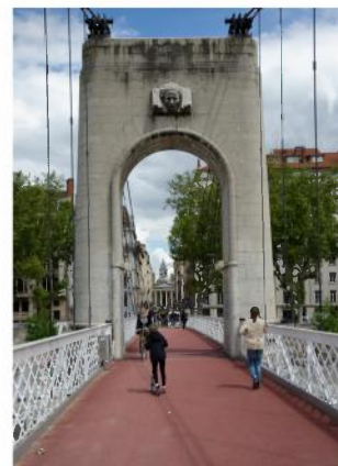
Accès côté Église Saint Pothin
