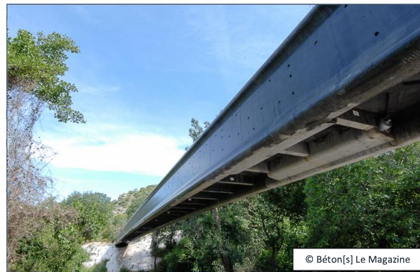
Vue générale de la passerelle
