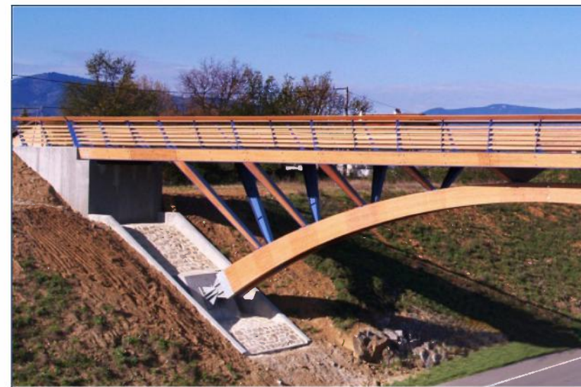
Détail des appuis de l'arc
