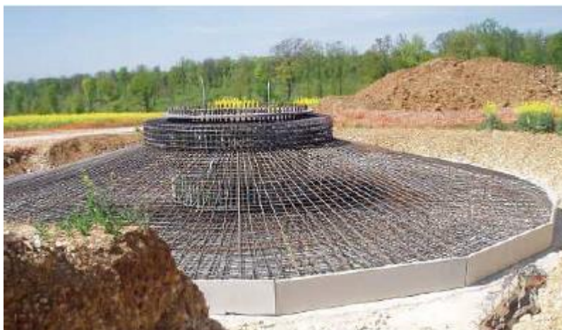
Figure III-4 : Ferrailage autour de la cage d'encrage d'une éolienne [Mic 16]
