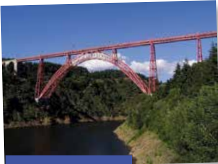
Viaduc de Garabit
