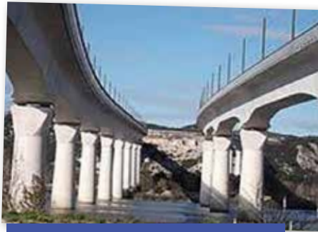
Viaduc TGV Avignon-Garrigue
